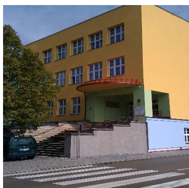
Budova školy Miřiovského 678
