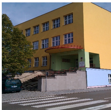
Budova školy Miřiovského 678
