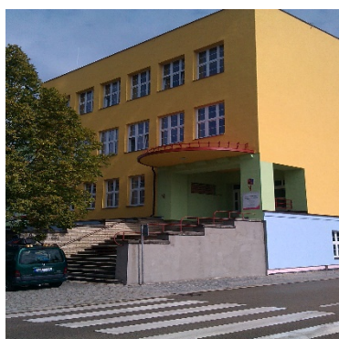
Budova školy Miřiovského 678
