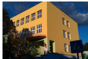
budova učiliště, Miřovského 678
