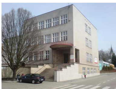
Budova školy Miřiovského
